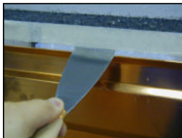
Abb. 10, 11: Den Dichtstoff sofort mit einem Spachtel oder mit dem Finger glätten. Anschliessend Abdeckbänder entfernen.
