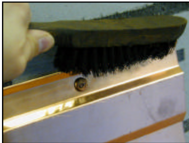
Abb. 6: Reinigen der Haftflächen: Sie müssen trocken, staub- und fettfrei sein. Evtl. mit Drahtbürste.
