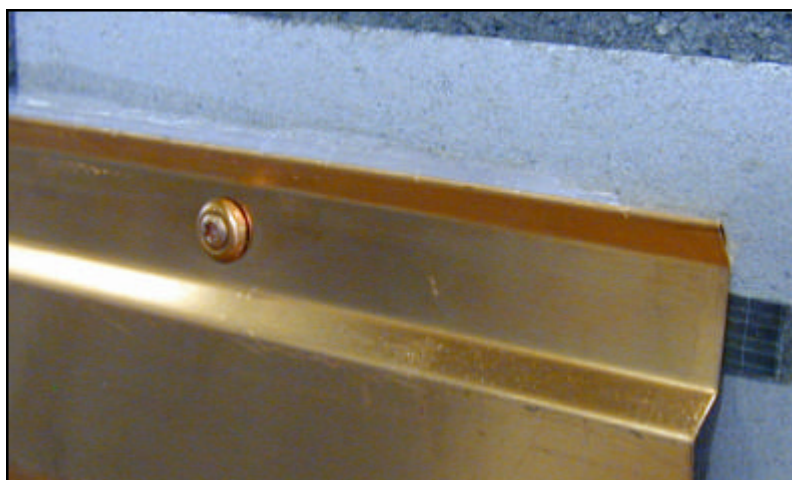
Abb. 1: Die Ausführung qualitativ einwandfreier Kittfugen ist anspruchsvoll
